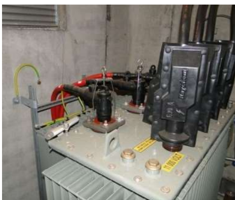
1682 1683 Links: isolerende afdekkappen; Rechts: omhulsel over alle LS-klemmen
