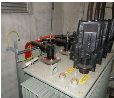
À gauche : capots isolants ; à droite : enveloppe
