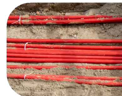
Câbles souterrains HT
