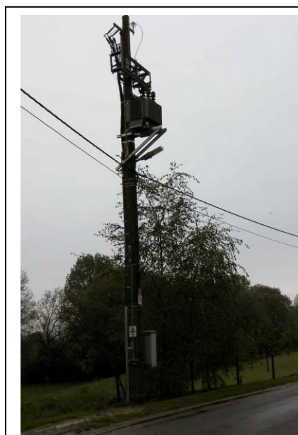
Transformateur à protections intégrées
