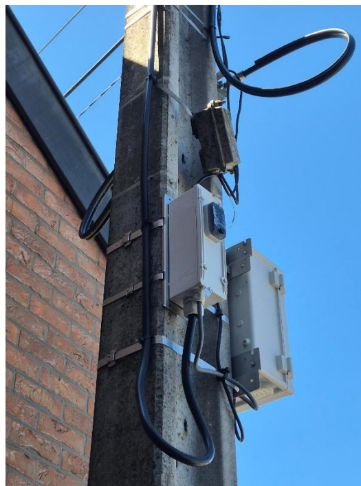
Exemples de pose sur poteau avec une dérivation sur un réseau de distribution aérien.
