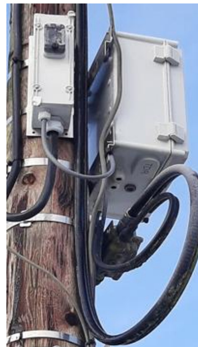
Voorbeelden van plaatsing op paal met een aftakking op een bovengronds distributienet.
